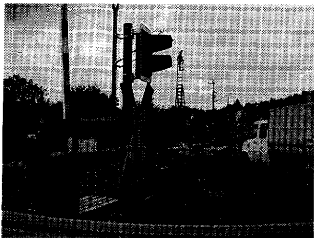
Während der Elektrifizierungsarbeiten im Bereich von Schopfloch.
